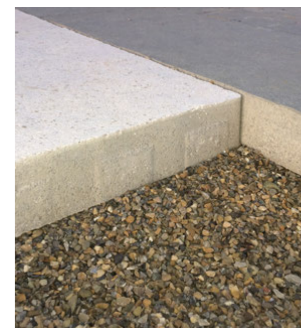
Particolare dello strato di allettamento di posa.
